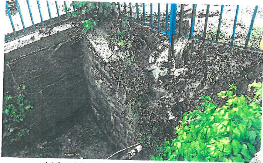
4.1.6.c/ A hidfő kimosódása a gáz nyomócsővel
