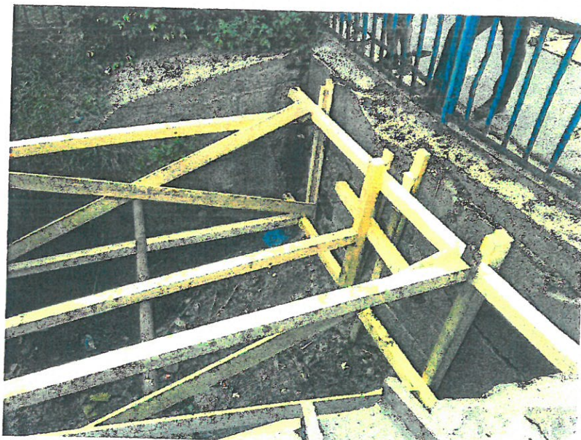
4.1.6.f/ Azonnali védekezés, dúcolás, járda elbontásával a hídfők betonozással való ideiglenes megerősítésével
