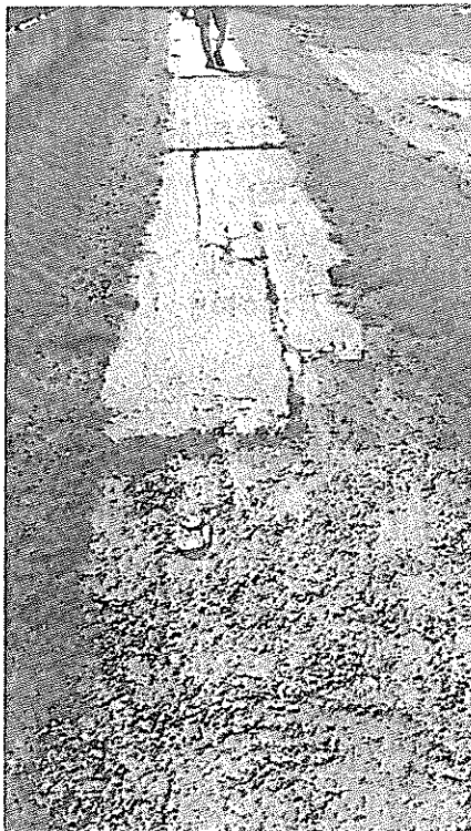
1./ PKS jelű beton födémpanelek hossz-, illetve keresztirányú repedései, felületi sérülések
