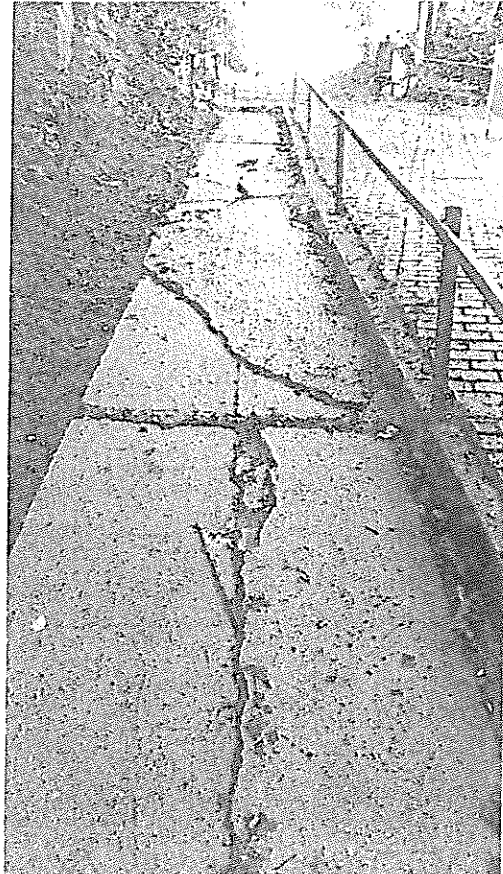
3./ Járda felvezetése a HÉV állomáshoz repedésekkel, sérülésekkel, korlát felújítással
