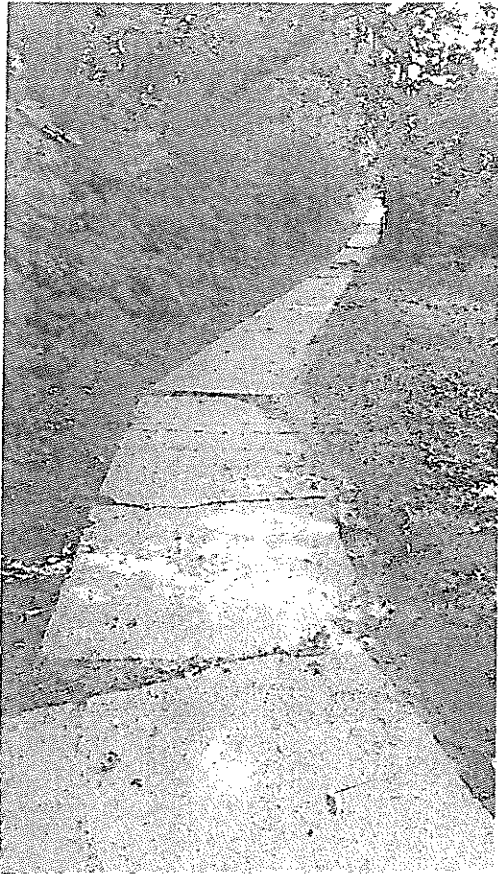
3./ Járda felvezetése a HÉV állomáshoz repedésekkel, sérülésekkel, korlát felújítással
