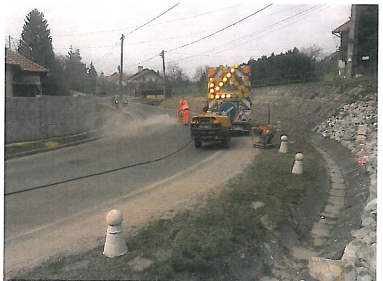
Aszfalt marását, hézag kiöntését végző géplánc
