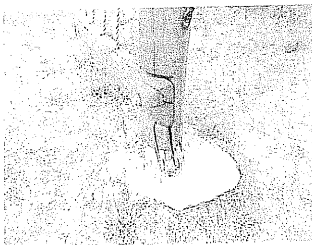
Törött tartóoszlop, kiálló alapozás ( 4. eszköz )
