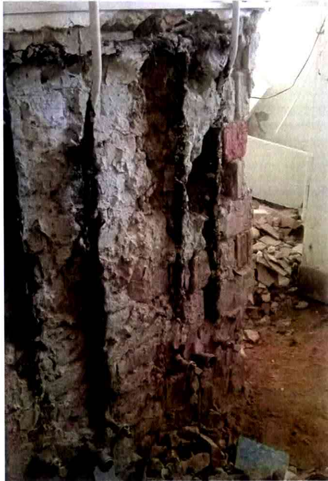
Korrodált csővezeték rendszer
