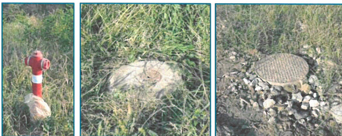
A FEJLESZTÉSI TERÜLETNÉL KIÉPÜLT TŰZIVÍZ-, IVÓVÍZ-, VALAMINT AZ ELVÁLASZTOTT RENDSZERŰ GRAVITÁCIÓS SZENNYVÍZHÁLÓZAT
