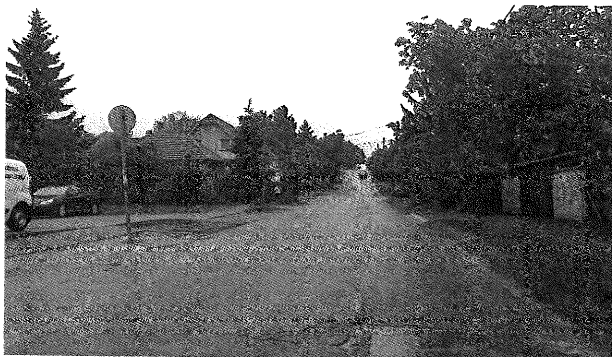
A Alföldi utca jellemző szelvénye 5,80 m pályaszélességgel, kátyúk javításával
