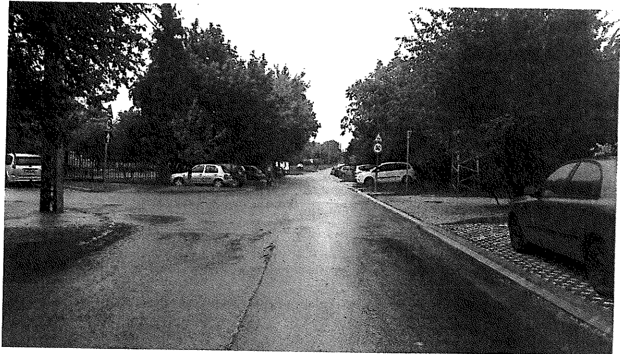
Vörösmarty utca útcsatlakozása balról, burkolat felújítás vége
