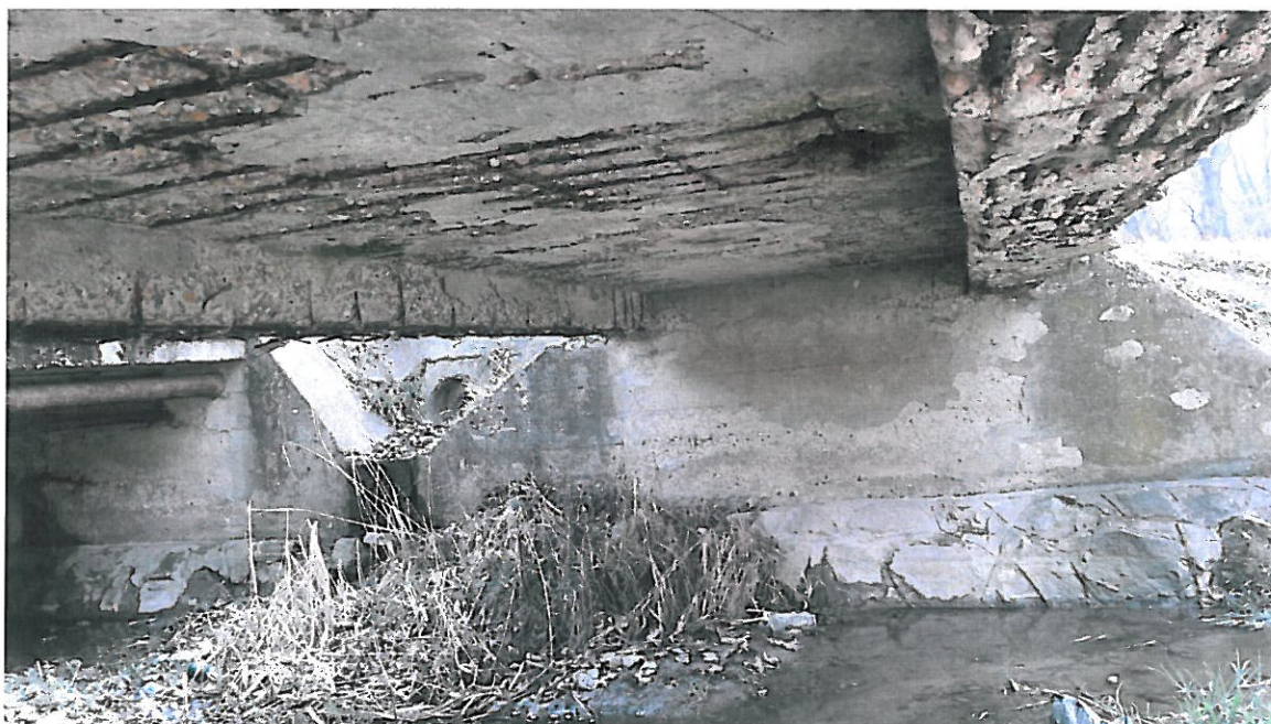
A hídszerkezet alulról a pályalemez átlukadásával
